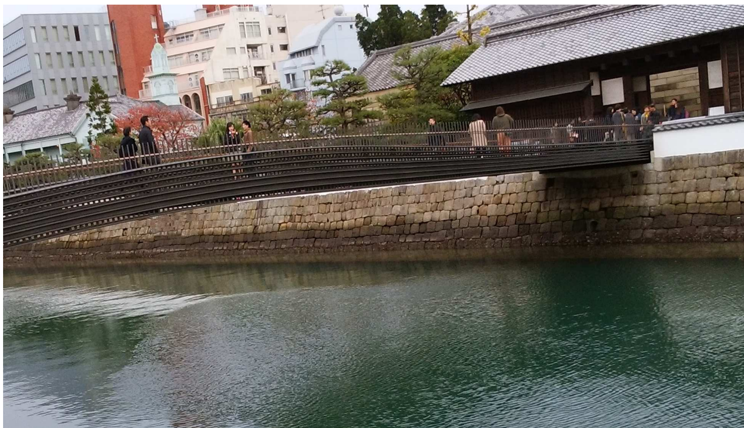
【出島は長崎港内に位置する埋立地であった。昭和 26 年より、元のとおりに復元しようとする壮大なプロジェクトが動いており、この橋もその過程である。】
